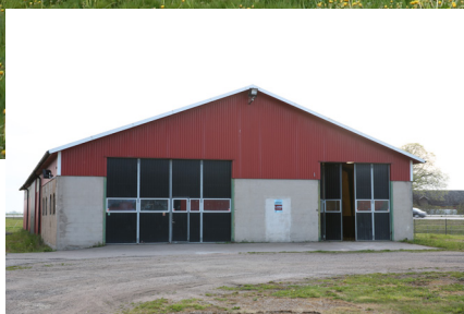
Entreq厂外景一派农野气息，更令笔者好奇不已。通过厂房的另一面，可推测厂内规模应该不小。
